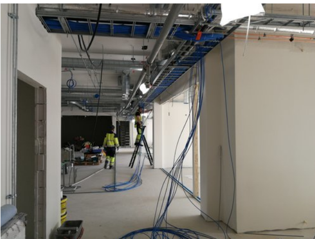
A2 2 krs tietoliikennekaapeleiden asennus käynnissä
