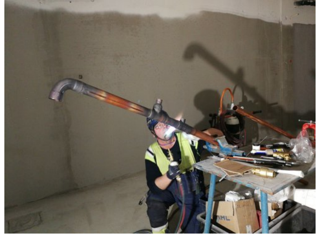
Kylmän vesijohdon syöttöputken rakentaminen lämmönjakohuoneeseen
