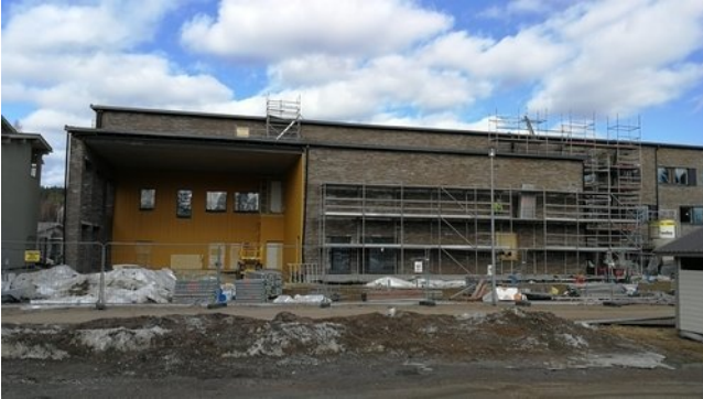
Eteläsivu lastauslaiturin - musiikkiluokan kohdalta
