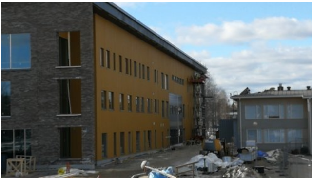
Pohjoisen sivun julkisivupaneelauksen vaihe
