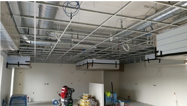
Opetuskeittiöissä alakattorunkotyöt valmistumassa
