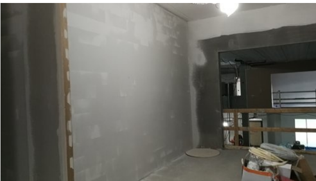
A1 2 krs tasoitetyöt käynnissä
