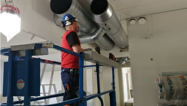
A2 lohkolla 3 krs IV-kanavien asennus aloitettiin tänään
