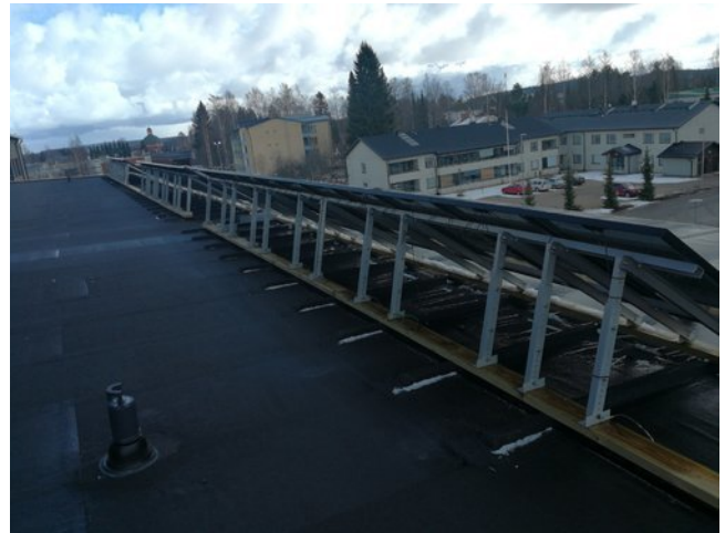
Kattopollareihin kiristysklemmarit asennettu
