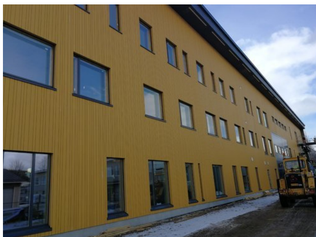
Julkisivupaneelauksen vaihe, ikkunoiden smyikit tehty
