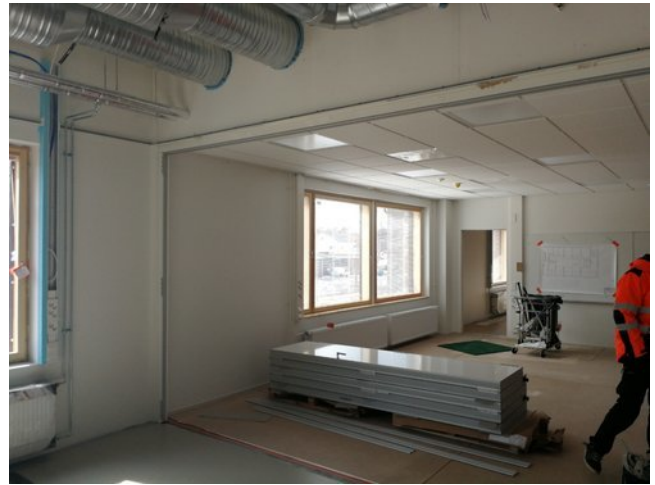
Ovi täytyi irrottaa mallihuoneesta 207 että saadaan viereiseen tilaan matto asennettua liukukiskoon kiinni.
