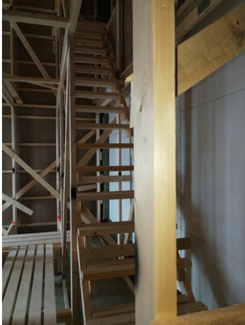
Portaat rakennettu ullakolla B-C/7-8 kohdalla IV-konehuoneen yläpohjaan pääsyä varten.
