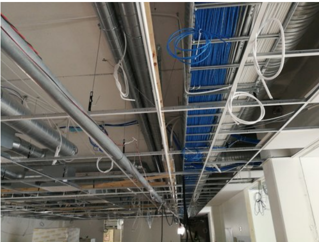
Tilanjako verho kisko asennettu A120-121
