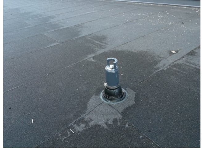
Kattopollareihin kiristysklemmarit asennettu
