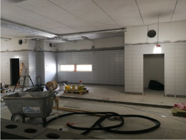
Yleiskuva keittiön laatoitusvaiheesta
