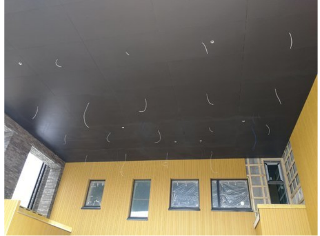
Lastauslaiturin alakaton rakennusvaihe
