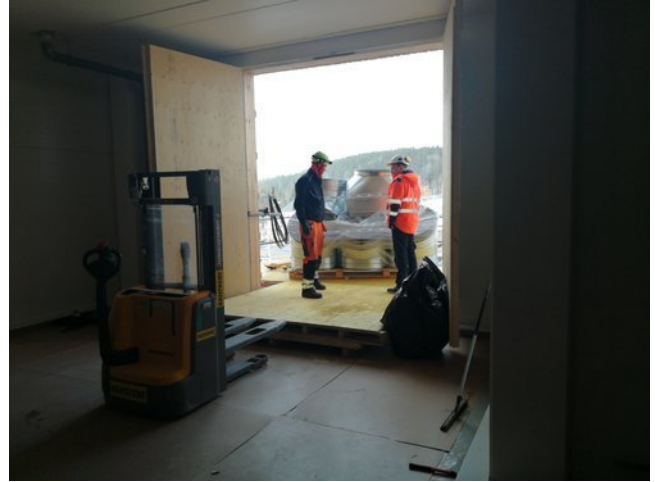
IV konehuoneeseen A335 kanavien osien toimitus aloitettu.
