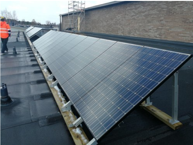
Vanhan koulun katolta aurinkopaneelit siirretty ja kiinnitetty lastauslaiturin katolle
