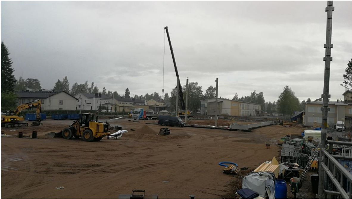
Sokkelipalkkien ja pilarien asennuksia.
