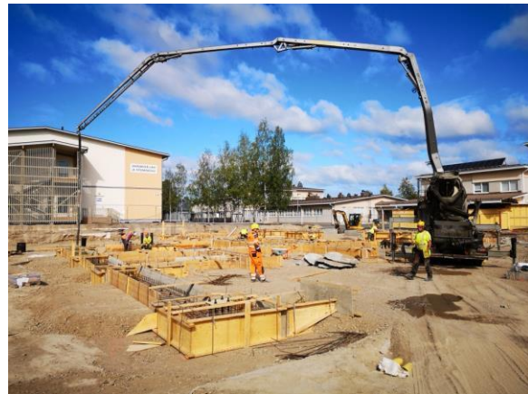
Betonivalutöitä, A1 anturat. Yleisnäkymä työmaalta.
