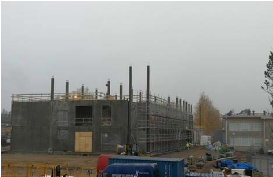
Työmaan vaihe itäpäädyssä.
