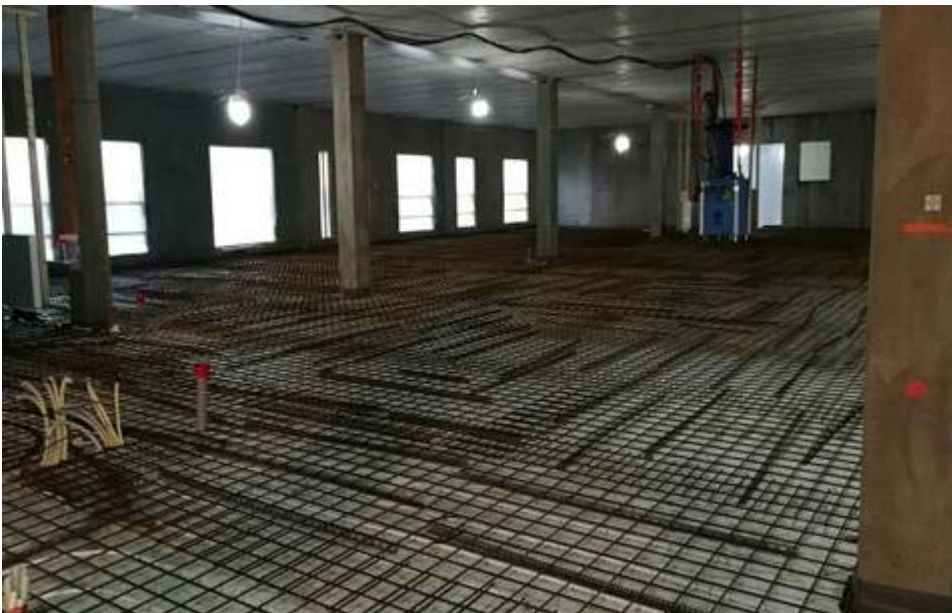
A2 osan 1 krs lattian rauditusvaihe.
