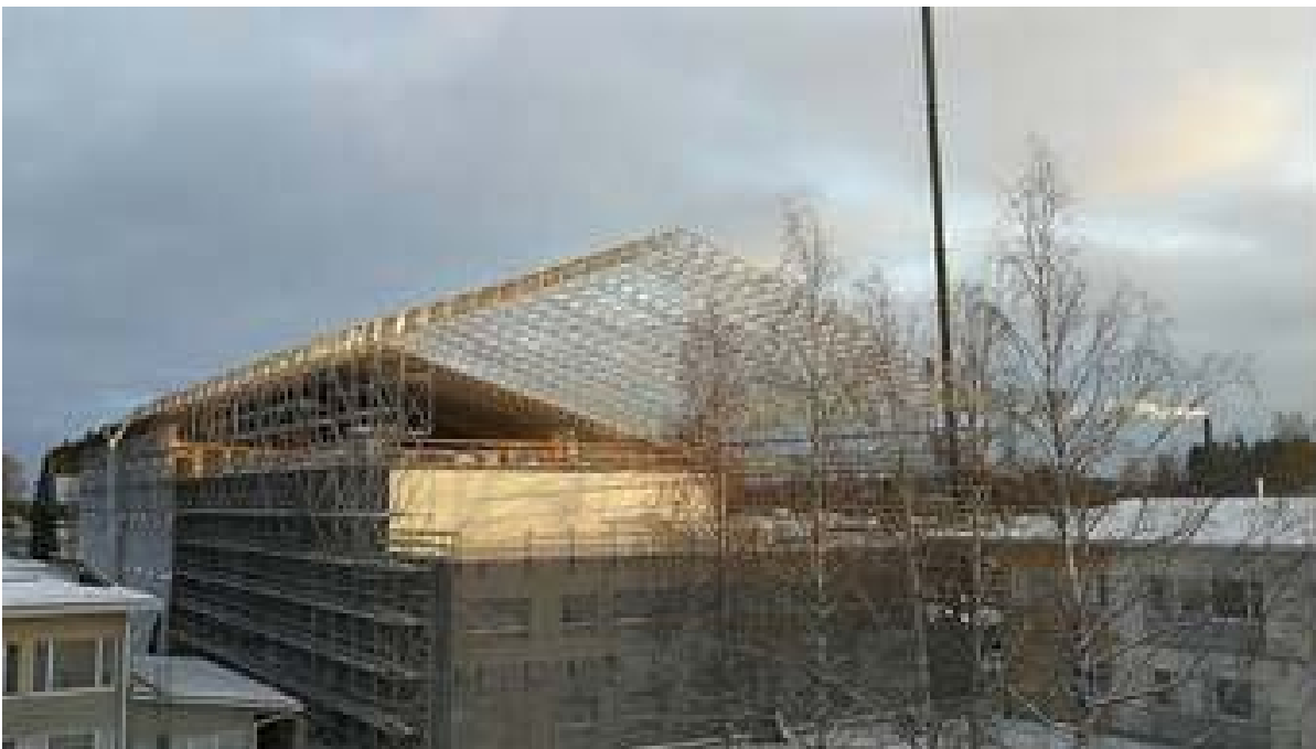
Sääsuojan rungon rakennusvaihe
