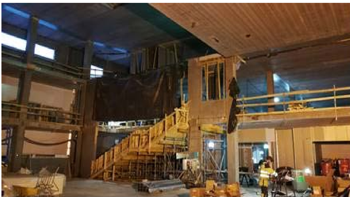
1 krs portaiden rakennusvaihe kulttuuriaulassa
