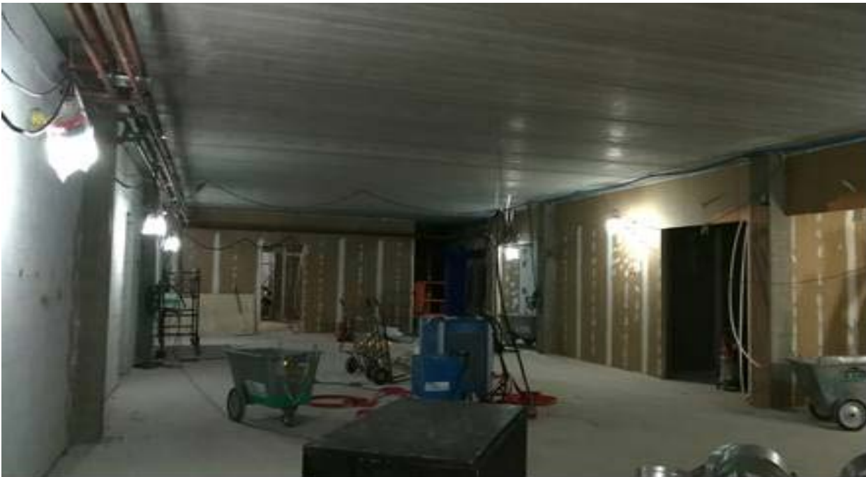
A2 osan 1 krs. väliseinät rakennettu / muurattu
