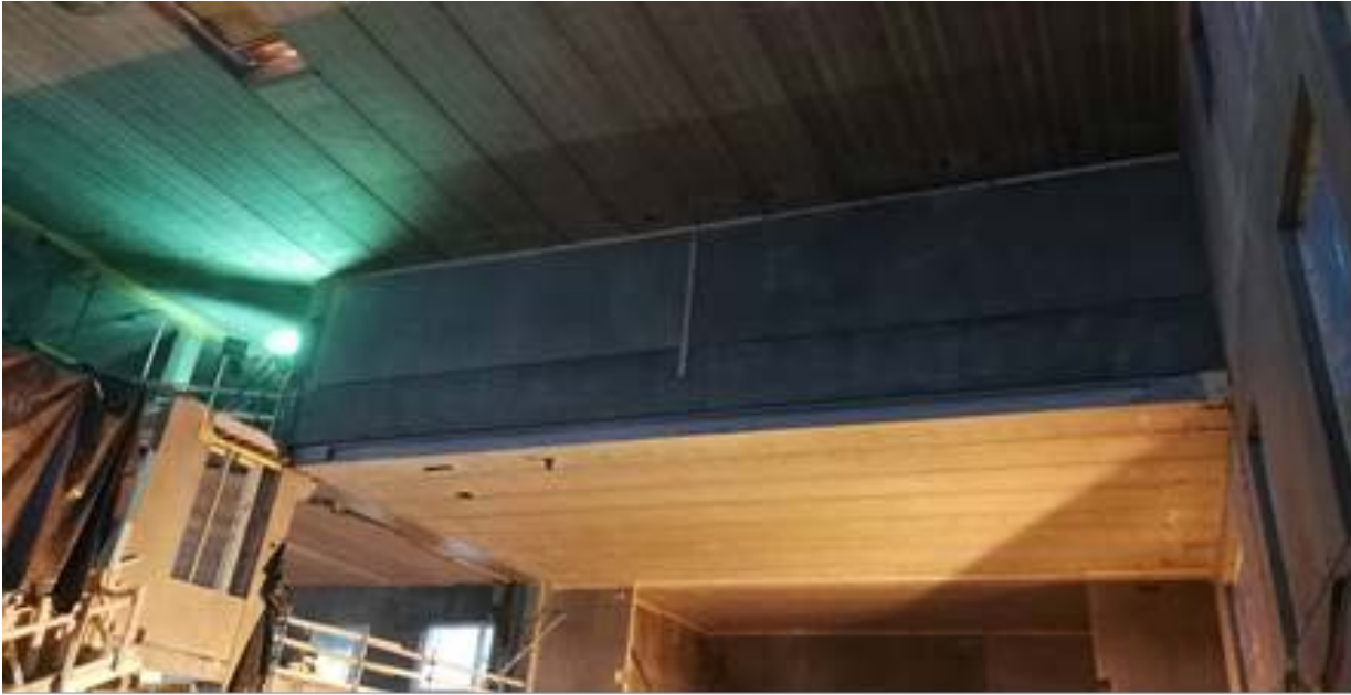
Kulttuuriaulan ontelot asennettu yläkattoon ja esiintymislavan kohdalle
