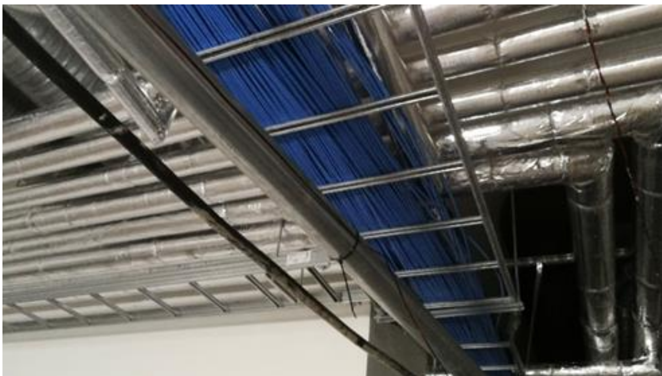
Tietoliikennekaapeleiden asennukset aloitettu.
