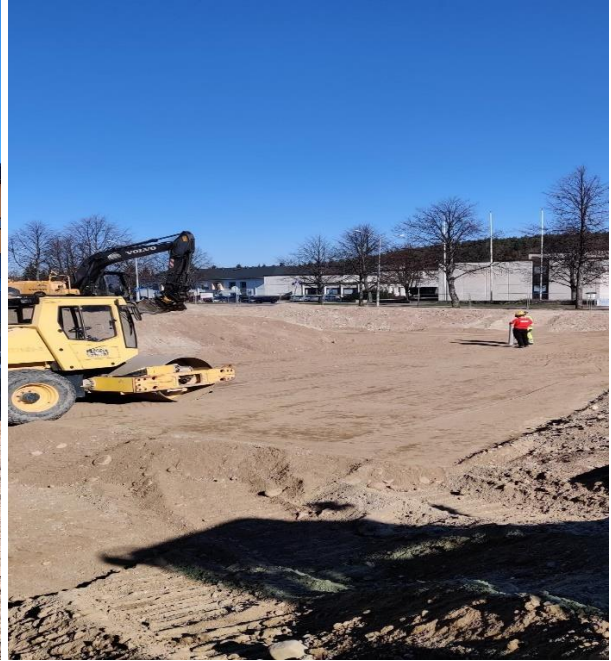
Maanrakennustöinä täytöt ja tiivistykset
