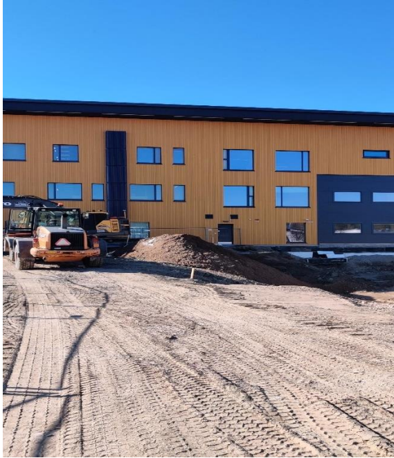
Maanrakennustöinä täytöt ja tiivistykset
