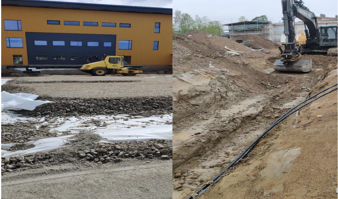
Maanrakennustöinä täytöt ja viemärilinjojen kaivu
