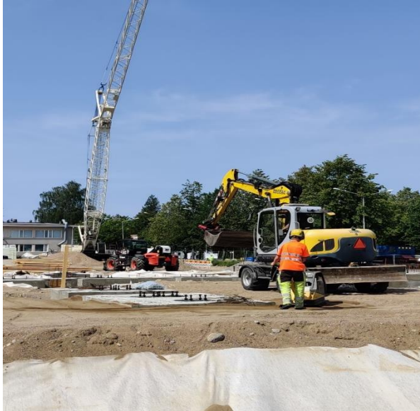
Sisäpuolen täyttöjä ja tiivistystä
