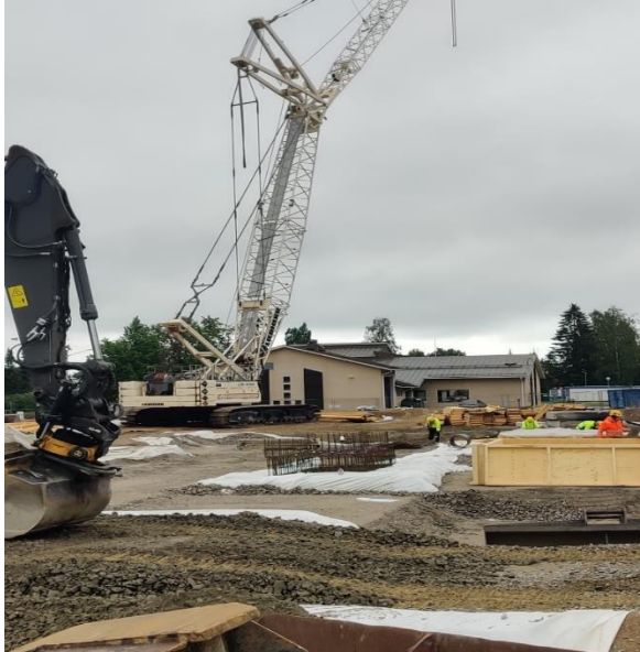
Nosturin asemointia elementtien asennukseen
