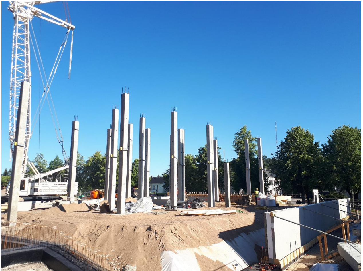
Pilari- ja sokkeliementtejä asennettu paikoilleen
