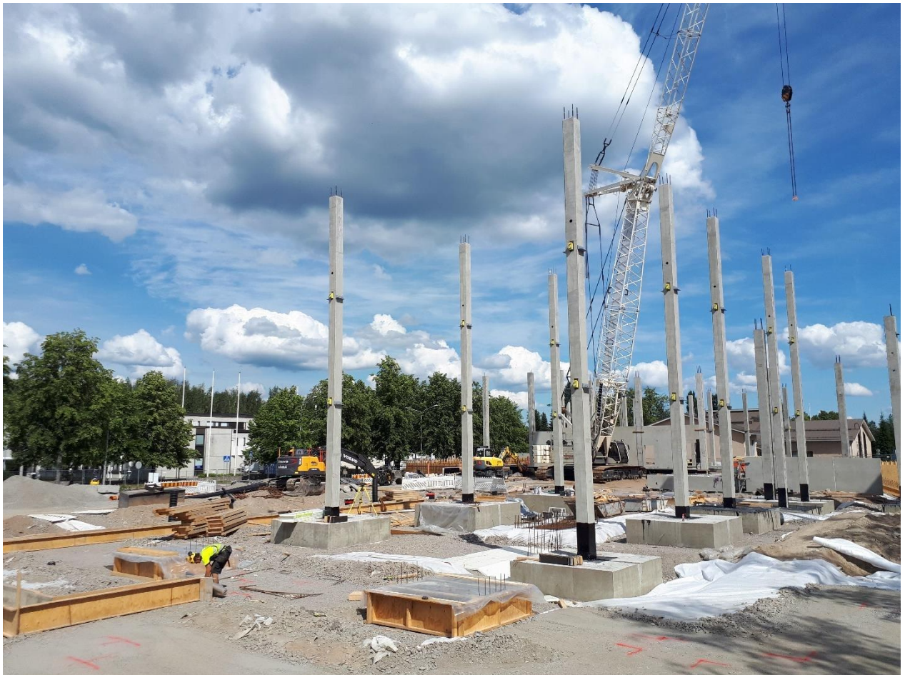
Pilari- ja sokkeliementtejä asennettu paikoilleen B-Lohko
