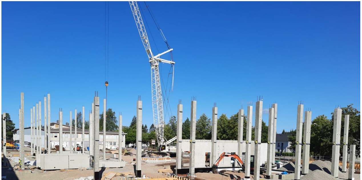
Pilari- ja sokkeliementtejä asennettu paikoilleen B ja C-Lohko
