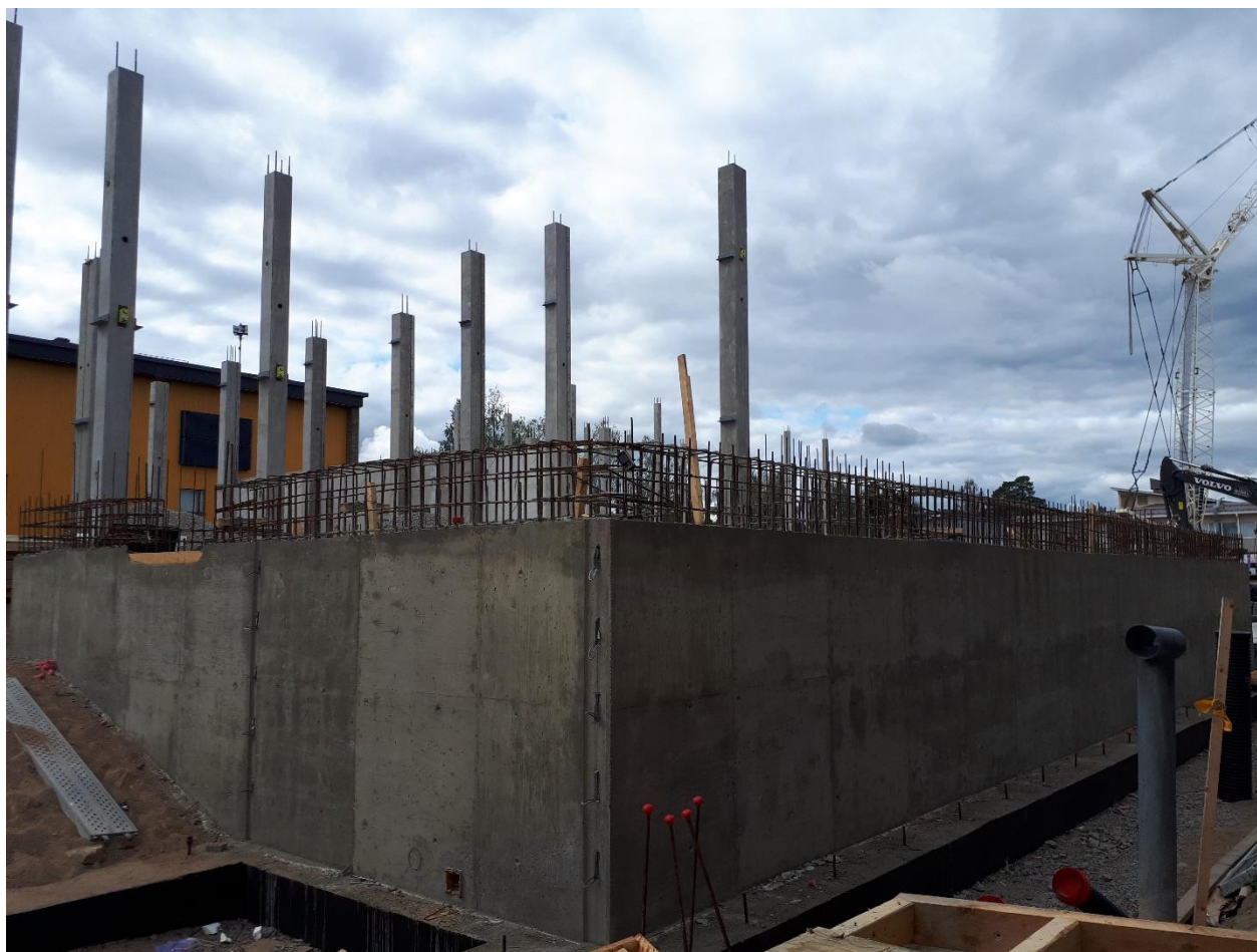
Väestösuoja 2, seinien korotusvalut tehty
