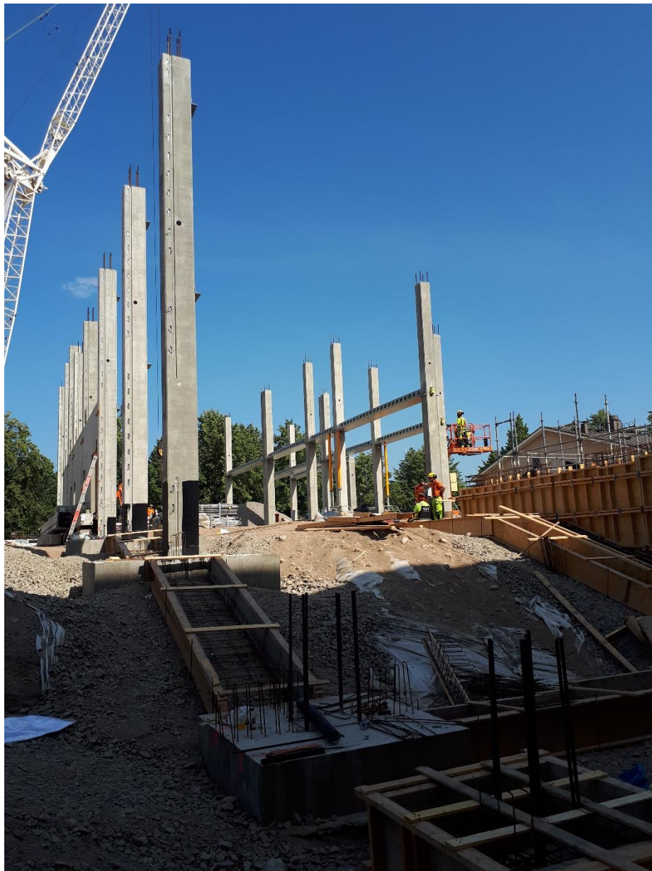
Delta-palkkien asennus käynnissä, Lohko C2
