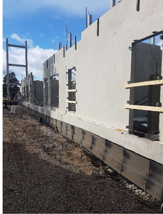
B-lohkon seinäelementtejä paikallaan
