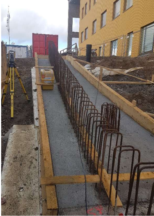
Alikulkutunnelin perustuksia valettu
